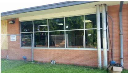
Seguin ECC new windows
