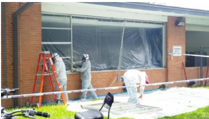
Seguin ECC window asbestos abatement
